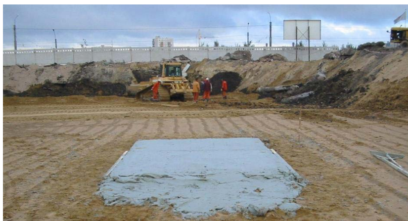
Формирование противофильтрационного слоя (Санкт-Петербург, квартал 9А-СУН)
