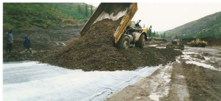
Рисунок 4. Разгрузка грунта из автосамосвала на пленку «щадящим способом»
