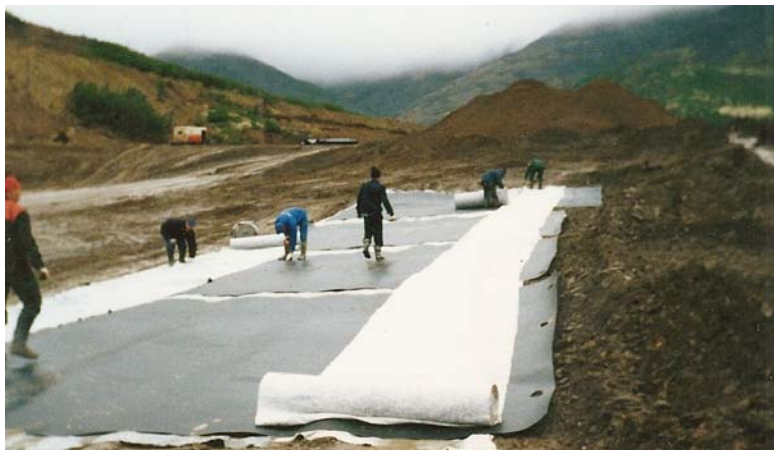
Рисунок 3. Закладка на опытном полигоне исследуемых фрагментов геомембраны
