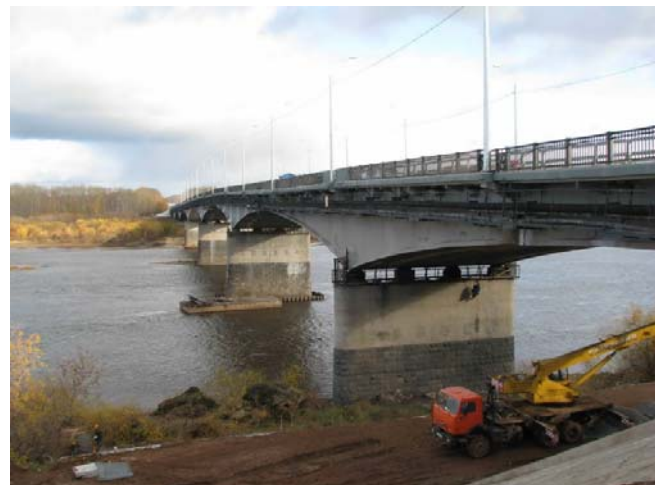
Рисунок 7. Фотография моста через реку Вятка с дорожной плитой из БЛН
