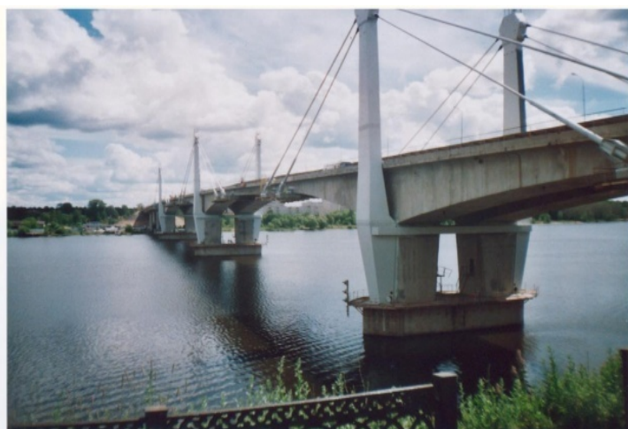
Рисунок 6. Мост через реку Волга в г. Кимры
