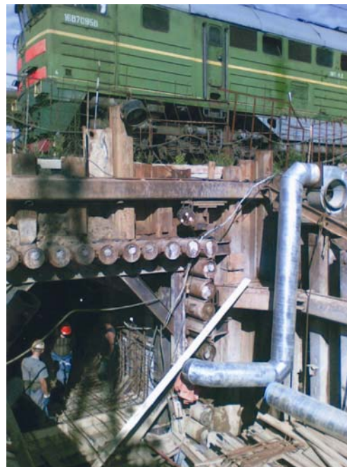
Рисунок 6. Сооружение пешеходного перехода
