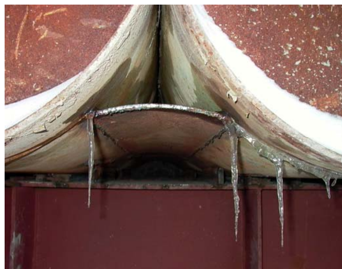
Рисунок 4. Устройство накладок на экран из труб для гидроизоляции тоннеля
