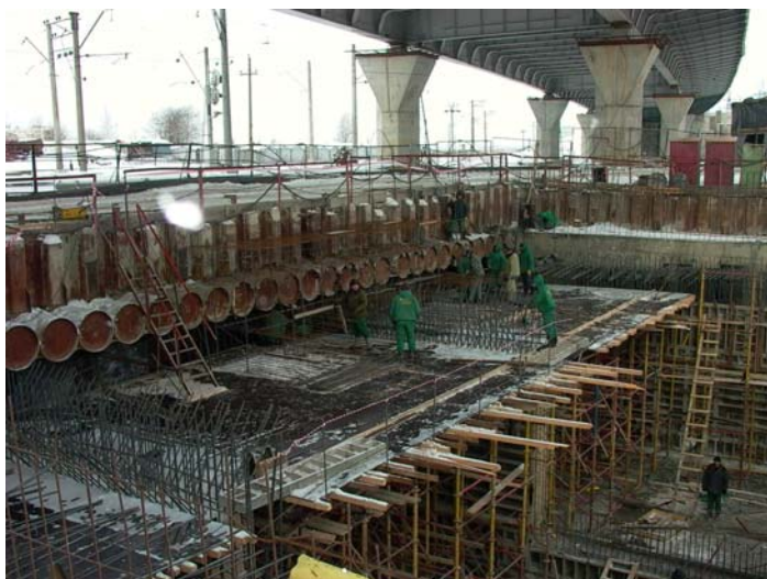
Рисунок 3. Вязка арматуры и монтаж опалубки для бетонирования порталов
