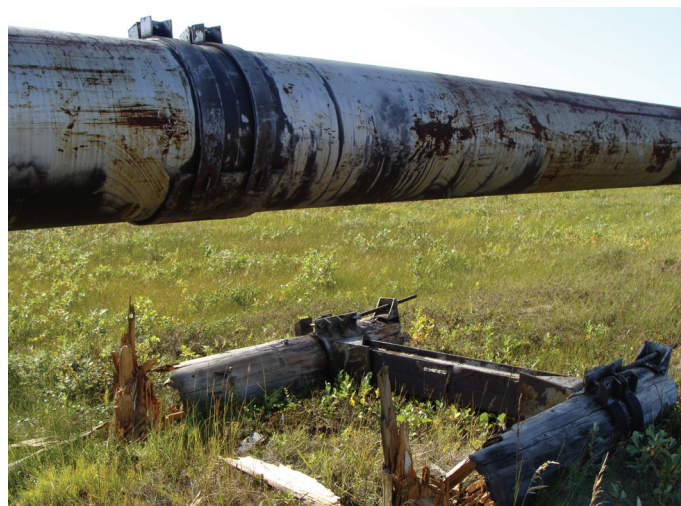
Рисунок 2. Увеличение пролета вследствие разрушения опоры
