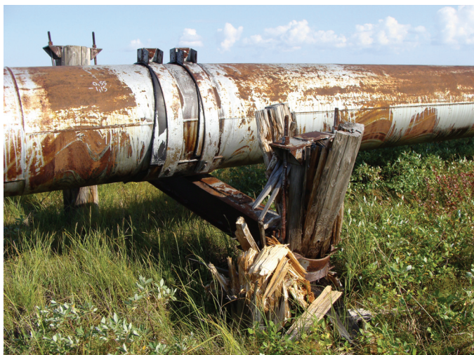
Рисунок 1. Выход из строя свайной опоры
