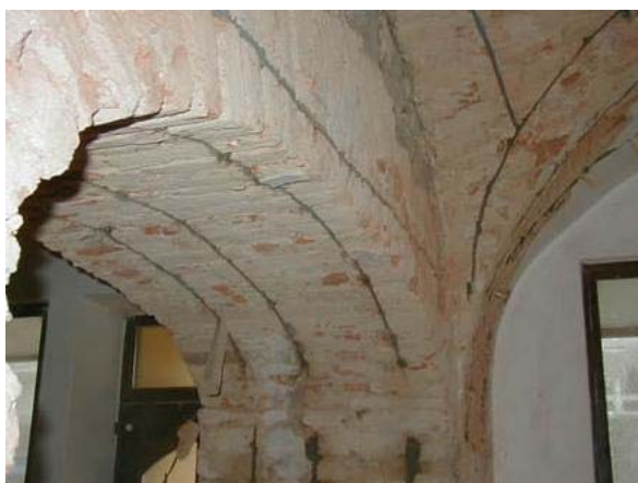
Рисунок 9. Усиление кирпичных сводов
