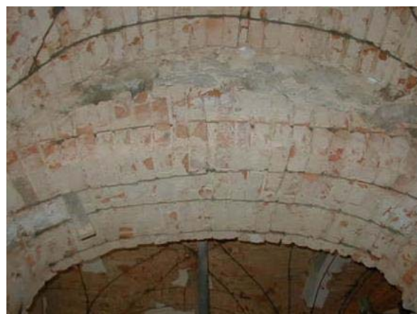
Рисунок 9. Усиление кирпичных сводов
