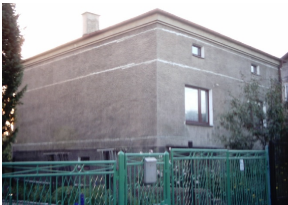
Рисунок 8. Усиление наружных стен, поврежденных трещинами
