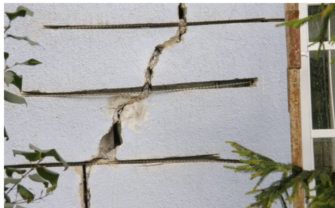
Рисунок 8. Усиление наружных стен, поврежденных трещинами
