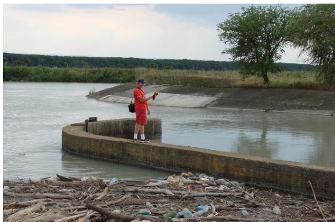
Рисунок 3. Обследование откосов шлюза-распределителя ГАЭС
