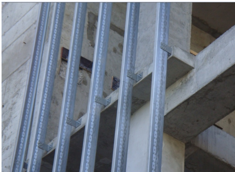
Рисунок 1. Вариант ограждающей конструкции: навесная конструкция стены
