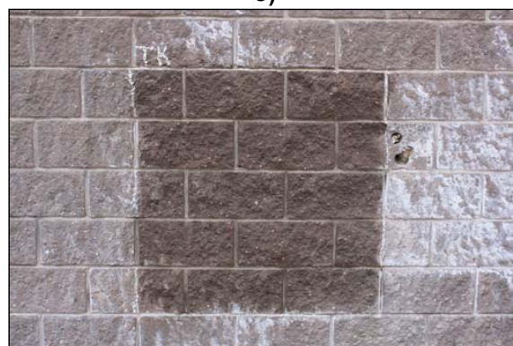
Рисунок 11. Блокировка высолообразования на поверхностях вибропрессованных бетонных блоков гидрофобизаторами Гидрощит-супер и Типром К Люкс, нанесенными непосредственно по высолом
