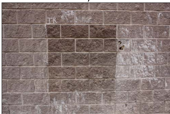
Рисунок 12. Гидрофобизация участка стены на основе вибропрессованных блоков Типромом К Люкс поверх высолов: а) участок стены, обильно покрытый высолом; б) участок стены после нанесения гидрофобизатора поверх высолов; в) участок стены после первого смыва высолов дождеванием и последующего осушения стены; г) участок стены в последующие циклы замачивания-осушения стены
