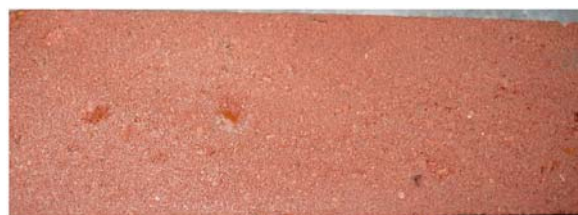
Рисунок 10. Нанесение гидрофобизатора непосредственно по высолом без предварительной очистки поверхности блоков
