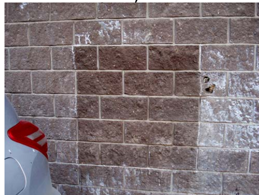
Рисунок 12. Гидрофобизация участка стены на основе вибропрессованных блоков Типромом К Люкс поверх высолов: а) участок стены, обильно покрытый высолом; б) участок стены после нанесения гидрофобизатора поверх высолов; в) участок стены после первого смыва высолов дождеванием и последующего осушения стены; г) участок стены в последующие циклы замачивания-осушения стены
