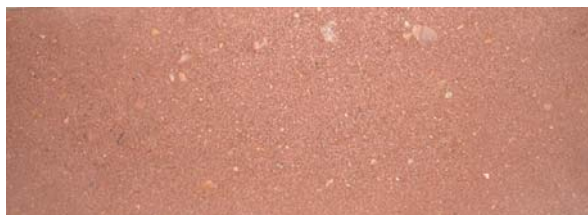
Рисунок 10. Нанесение гидрофобизатора непосредственно по высолом без предварительной очистки поверхности блоков
