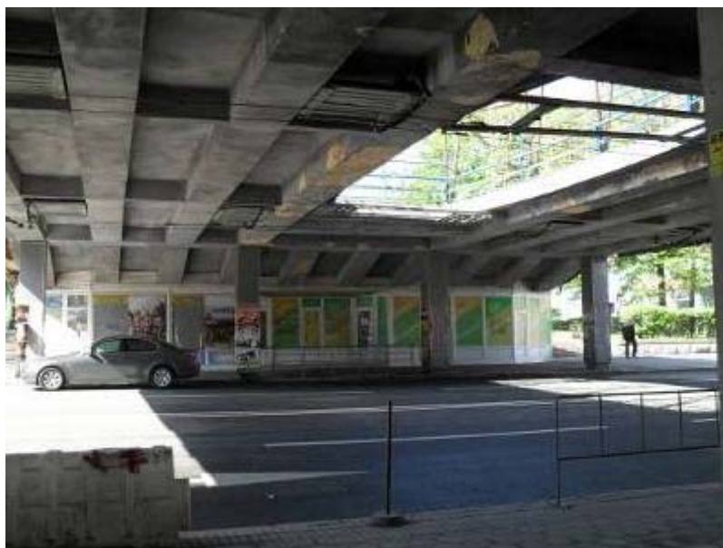
Рисунок 1. Эстакада. Вид снизу на пролетное строение
