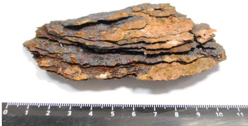
Рисунок 6. Слоистые коррозионные окислы, отобранные с балок перекрытия
