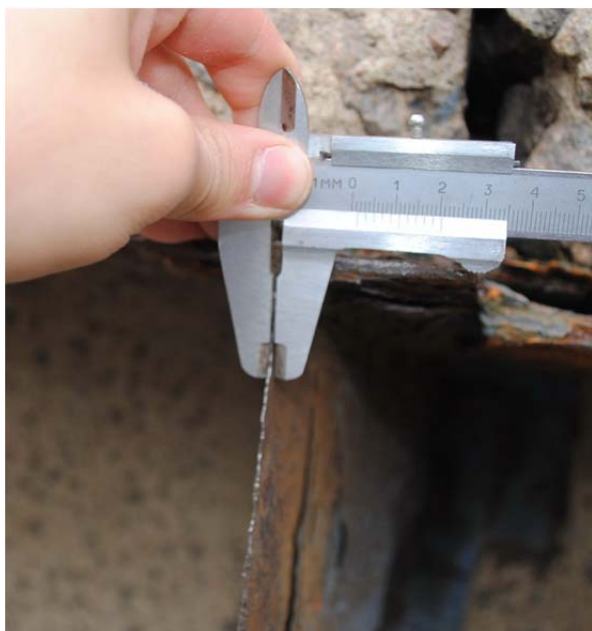
Рисунок 2. Измерение остаточной толщины штангенциркулем
