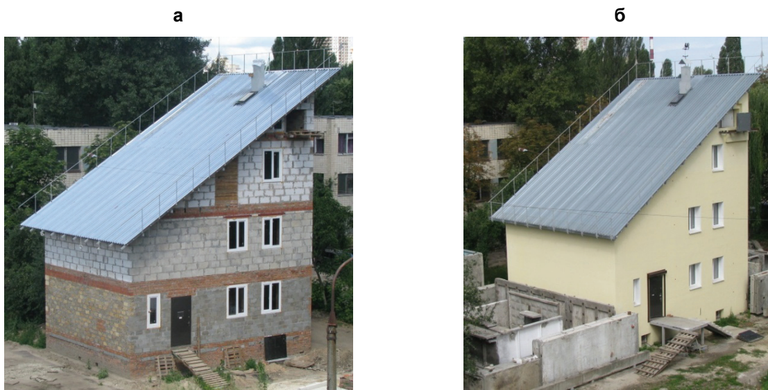
Рисунок 1: а) общий вид пассивного дома; б) пассивный дом с утеплением ограждающих конструкций
